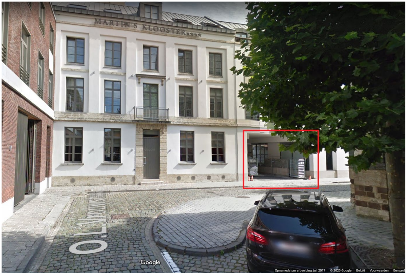
Doorgang Kloosterhotel ->laad-los zone 1
